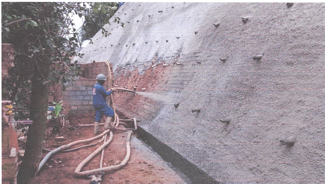
* Foto da Obra Meta 4 Rua Represa de Pirajá - Localizada no Bairro de Pirajá em Salvador-Ba com execução de Contenção em Solo Grampeado com utilização de tela metálica e revestimento de face em Concreto Projetado. Fotografia com evidência do funcionário executando serviço de concreto projetado no talude.
