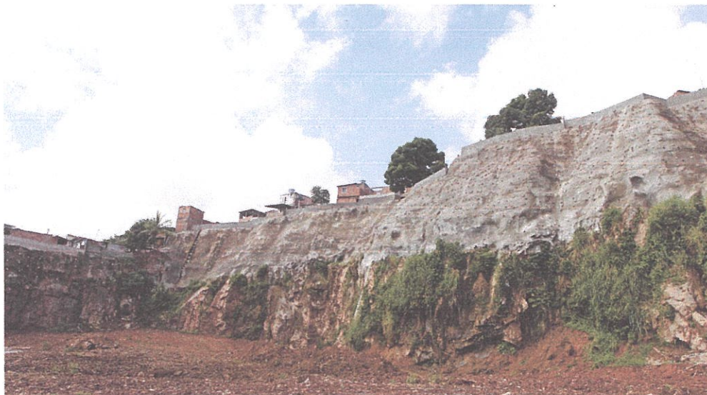
* Foto da Obra PDE 013 - Pedreira Limoeiro localizado no Bairro da Palestina em Salvador-Ba com execução de Contenção em Solo Grampeado com utilização de tela metálica e revestimento de face em Concreto Projetado.
