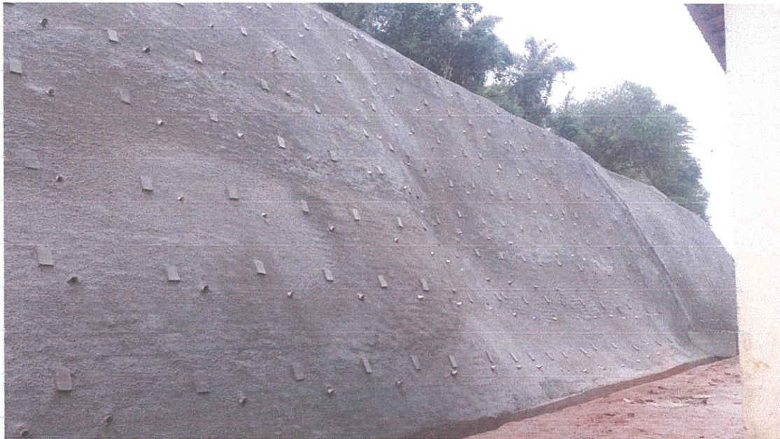
* Foto da Obra Meta 4 Rua Represa de Pirajá - Localizada no Bairro de Pirajá em Salvador-Ba com execução de Contenção em Solo Grampeado com utilização de tela metálica e revestimento de face em Concreto Projetado.
